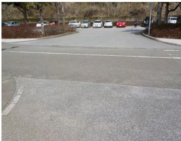
施設への出入口の状況
