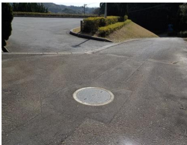
施設への出入口の状況
