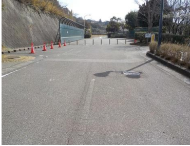
施設への出入口の状況
