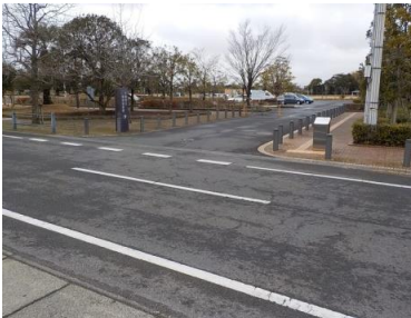
施設への出入口の状況
