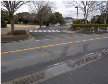
施設への出入口の状況
