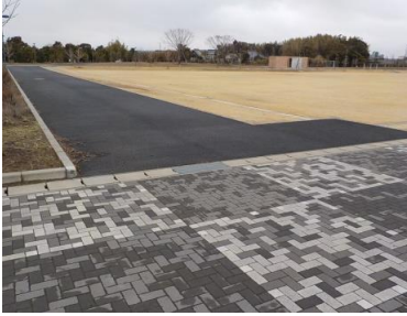
施設への出入口の状況
