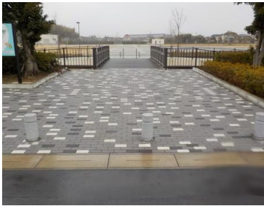
施設への出入口の状況
