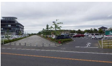
施設への出入口の状況
