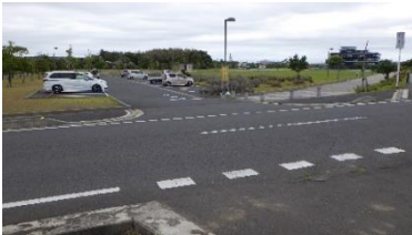
施設への出入口の状況
