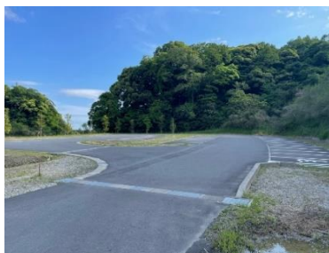
施設への出入口の状況
