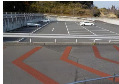
施設内広場等の状況
