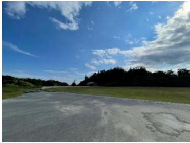
施設への出入口の状況
