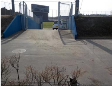
施設への出入口の状況
