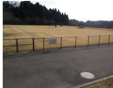
施設内広場等の状況
