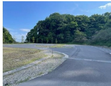
施設内広場等の状況
