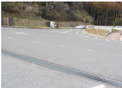
施設への出入口の状況
