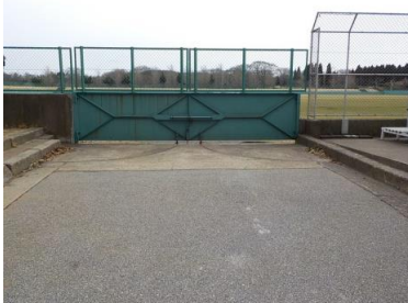
施設への出入口の状況
