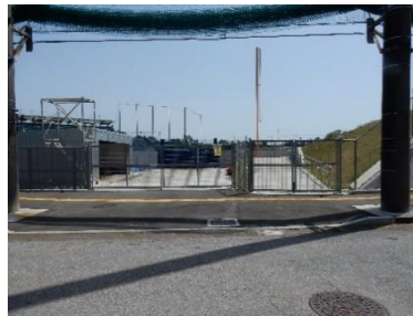
施設への出入口の状況
