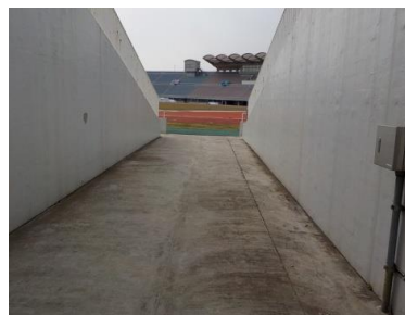
施設への出入口の状況
