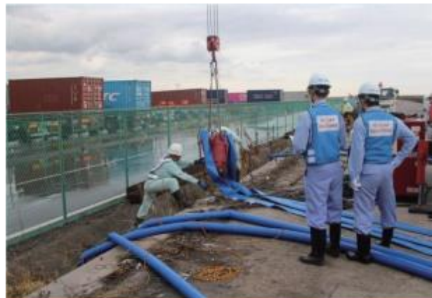
ふ頭の冠水箇所における排水支援
