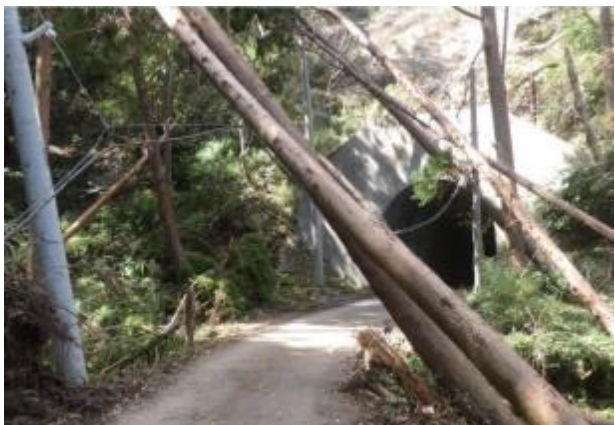
倒壊電柱・倒木の状況(千葉県鴨川市)
