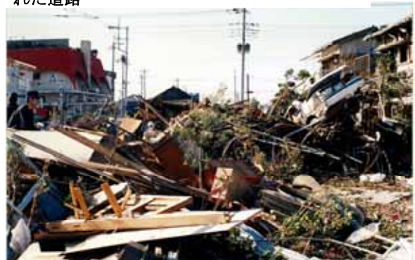
④竜巻で破壊された建物の残骸で埋め尽くされた道路
