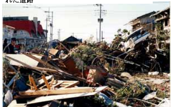
④竜巻で破壊された建物の残骸で埋め尽くされた道路
