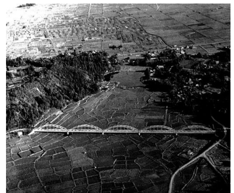
写真1 完成当初の公平水路橋（東金市）
