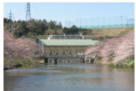
写真2 両総用水第1機場（香取市）
