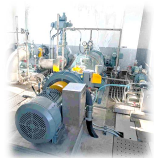
ポンプ設備の更新
