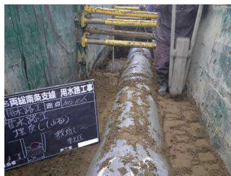
用水管布設状況（道路下）
