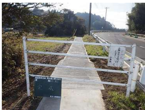
用水管理設（開水路内）
