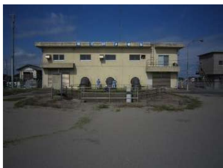
堀川排水機場(全景)
