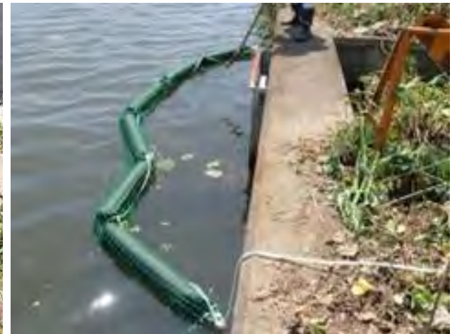
流出防止を目的としたダストフェンスの設置例
