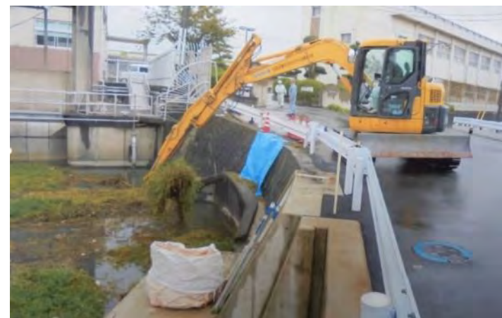
重機による駆除事例
