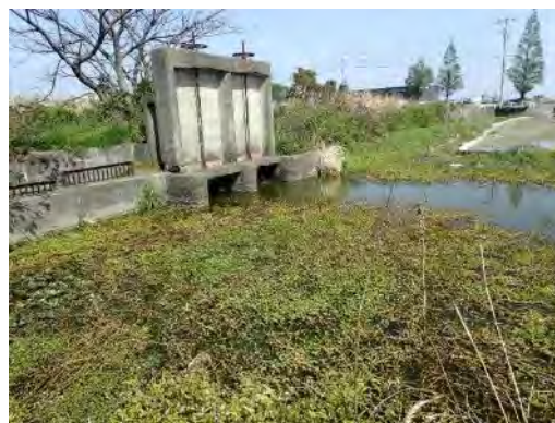
水路を閉塞し、取水・排水の障害となる
