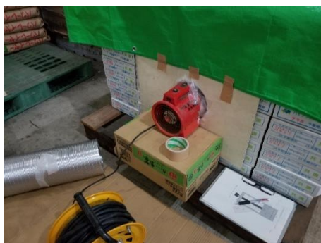
写真1 差圧ファンの設置
