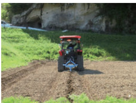
写真1：カットドレーン mini による暗きよ施工
