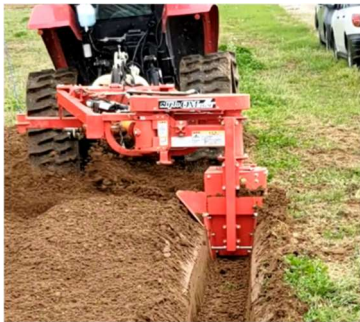
写真1 額縁明きょ施工
