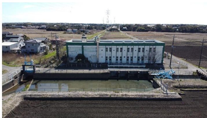
<新宿揚水機場>
