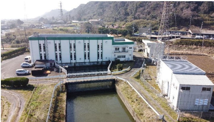
<笹川揚水機場>
