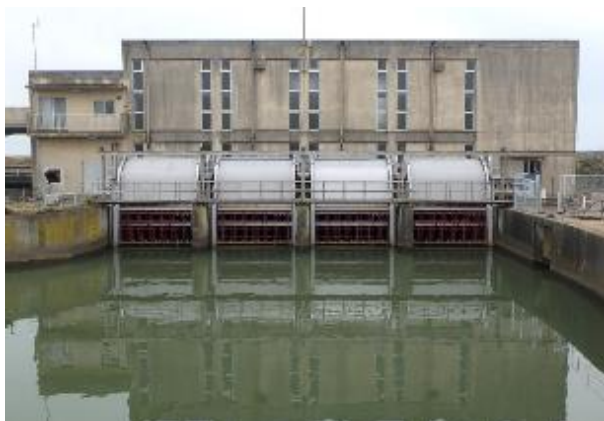
<大布川排水機場>
