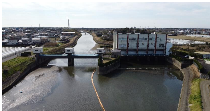
<新川用排水機場>
