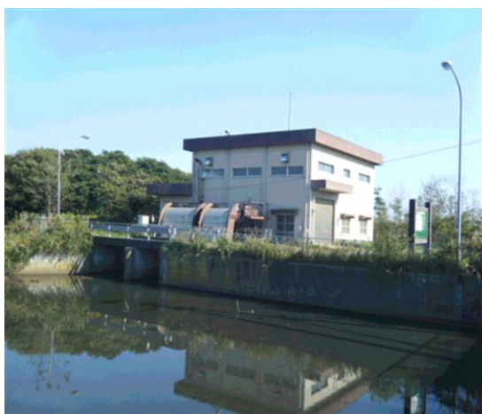
<野田排水機場>
