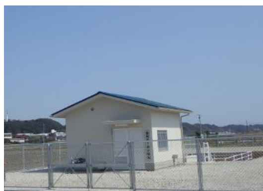
<用水を安定供給する揚水機場>
