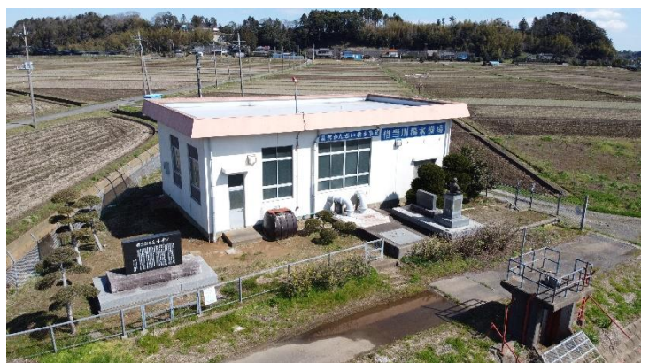
<借当川揚水機場>
