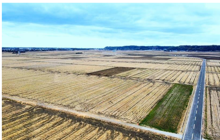
< 暗渠排水施工後のほ場 >
