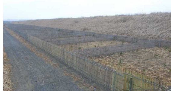
海岸県有保安林内の植栽工事
