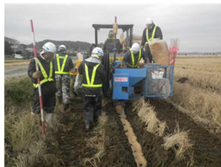
暗渠排水の施工状況
