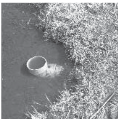
(写真1)土排水路とつながるパイプ
