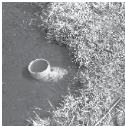
(写真1)土排水路とつながるパイプ
