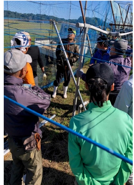
図 1. 研究部の棚補修研修
