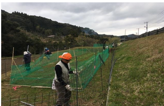
防護柵の設置作業
