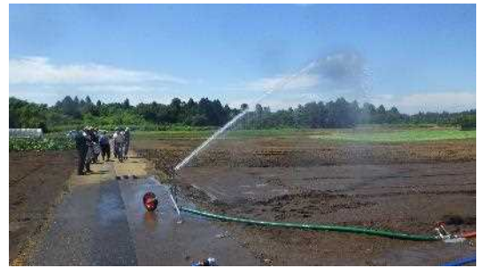
北総中央用水を使った新型スプリンクラーによる散水試験(千葉市緑区中野町)
