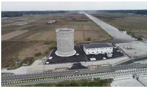
国営事業により更新されている 基幹用排水機場
