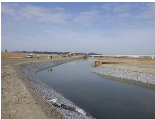
排水路の整備による湛水被害 防止対策
