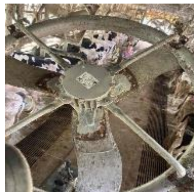
写真2 送風機の清掃後
