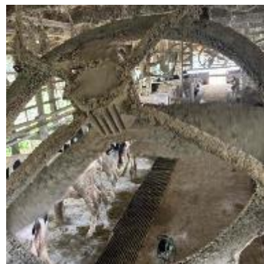
写真1 送風機の清掃前
