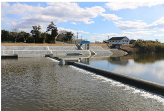
基盤整備事業で整備した取水堰 （養老堰）
