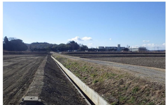
基盤整備事業の状況 （区画整理、農道、排水路整備）
