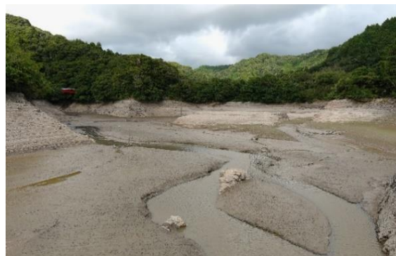
安房中央ダム（堆砂状況）
