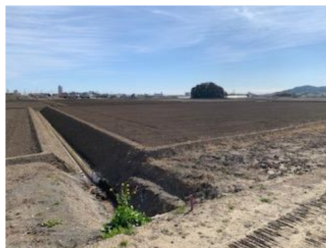
区画整理工事（加茂川中部地区）
