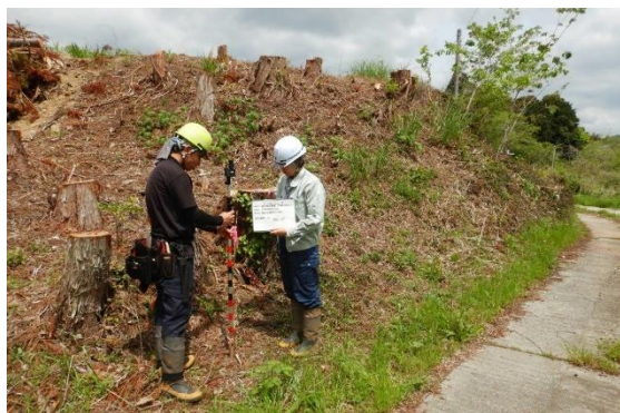
衛星測位システムを活用した測量・現地確認
