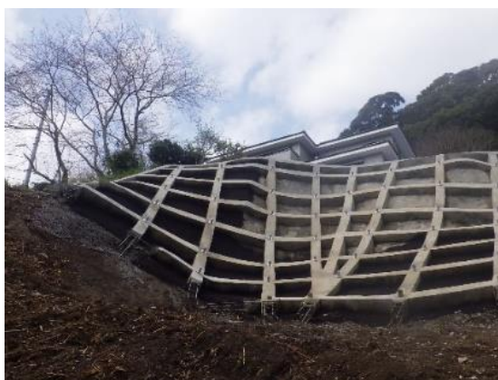
地すべり対策工事（県単奥山地区）
