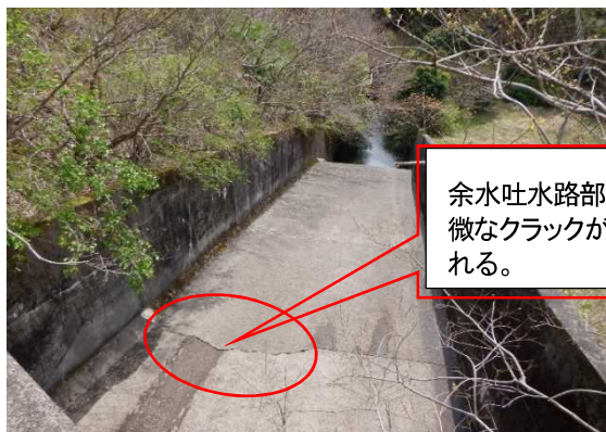
金山ダム余水吐（加茂川左岸地区）
