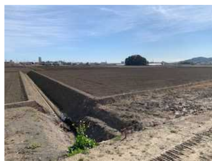
区画整理工事 (加茂川中部地区)
