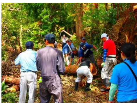
台風被害から農道復旧に取り組むびわ生産者
