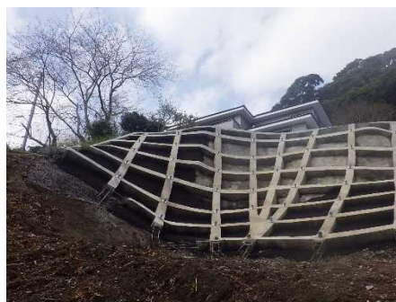
地すべり対策工事（県単奥山地区）
