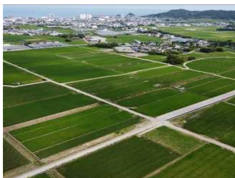
令和3年度からほ場整備後の耕作が始まった加茂川中部地区
