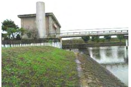
排水機場の法面での生育状況
