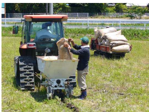
もみ殻補助暗渠の設置
